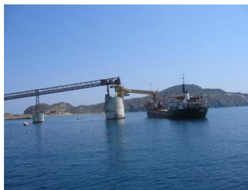
Εγκαταστάσεις Μεταφοράς ελαφρόπετρας (Θέση 19)
