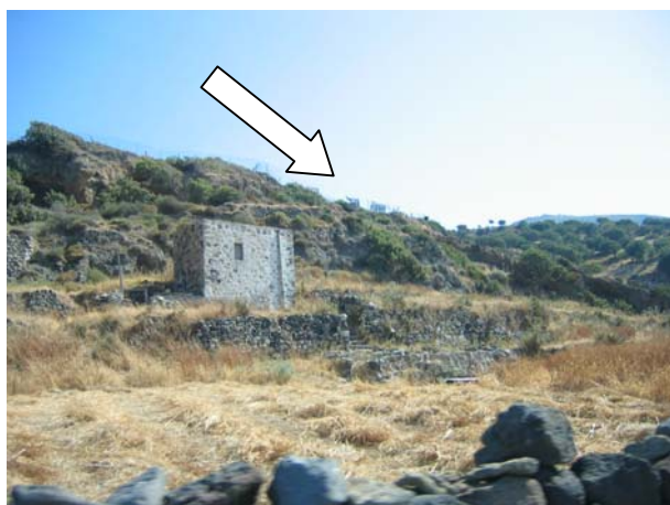
Εικόνα 27: Κατεστραμμένοι φυτοφράκτες από τα ζώα ελευθέρως βοσκής
