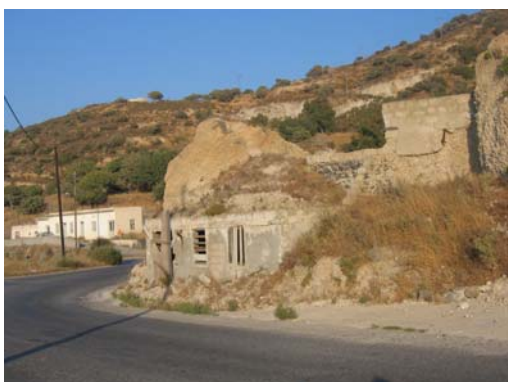
Εγκαταλελειμμένα σπίτια στη διαδρομή προς του Πάλους (Θέση 9)
